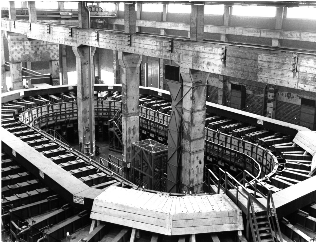
Une des 96 chambres d'un calutron \alpha
