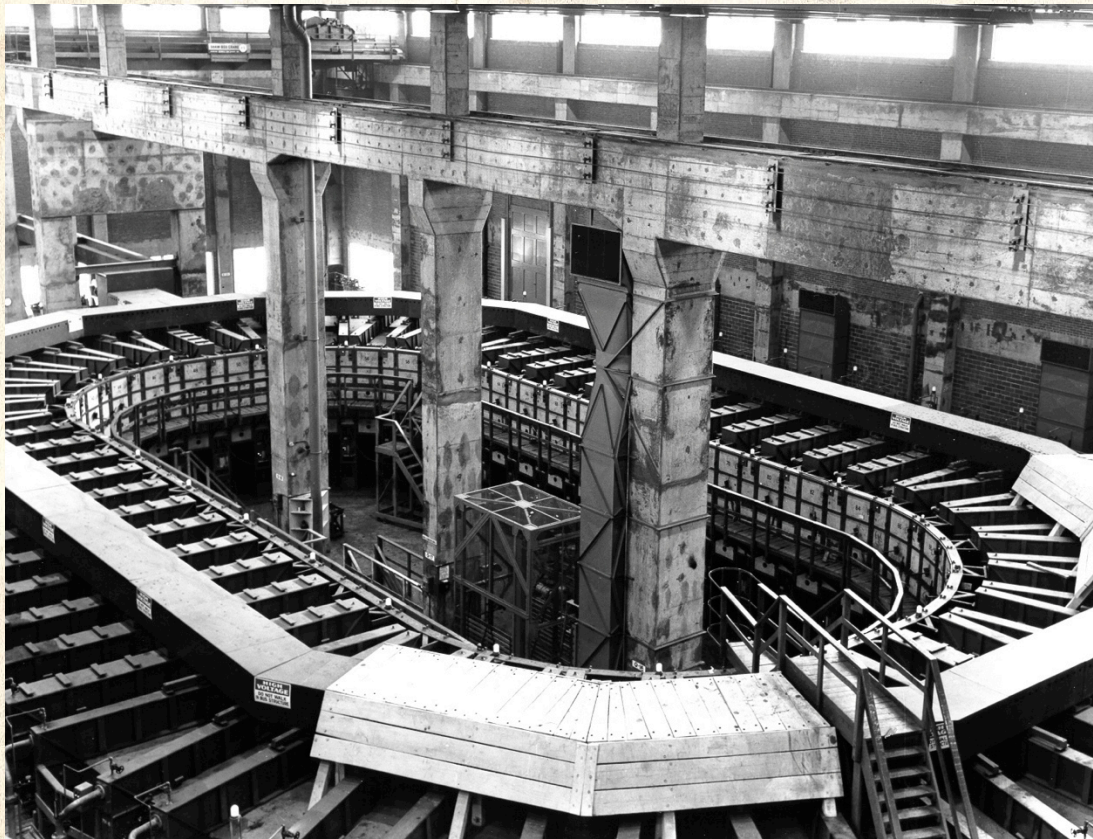
Une des 96 chambres d'un calutron \alpha
